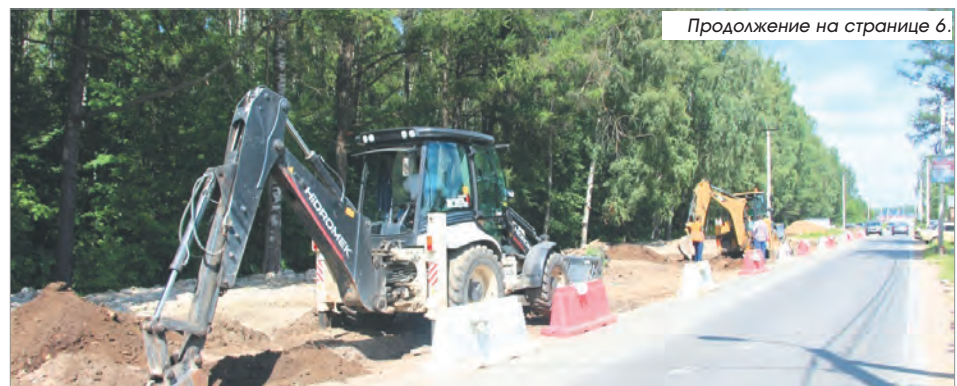
Реконструкция 1-й линии в Янино-1 с расширением проезжей части и устройством тротуаров с ограждениями
